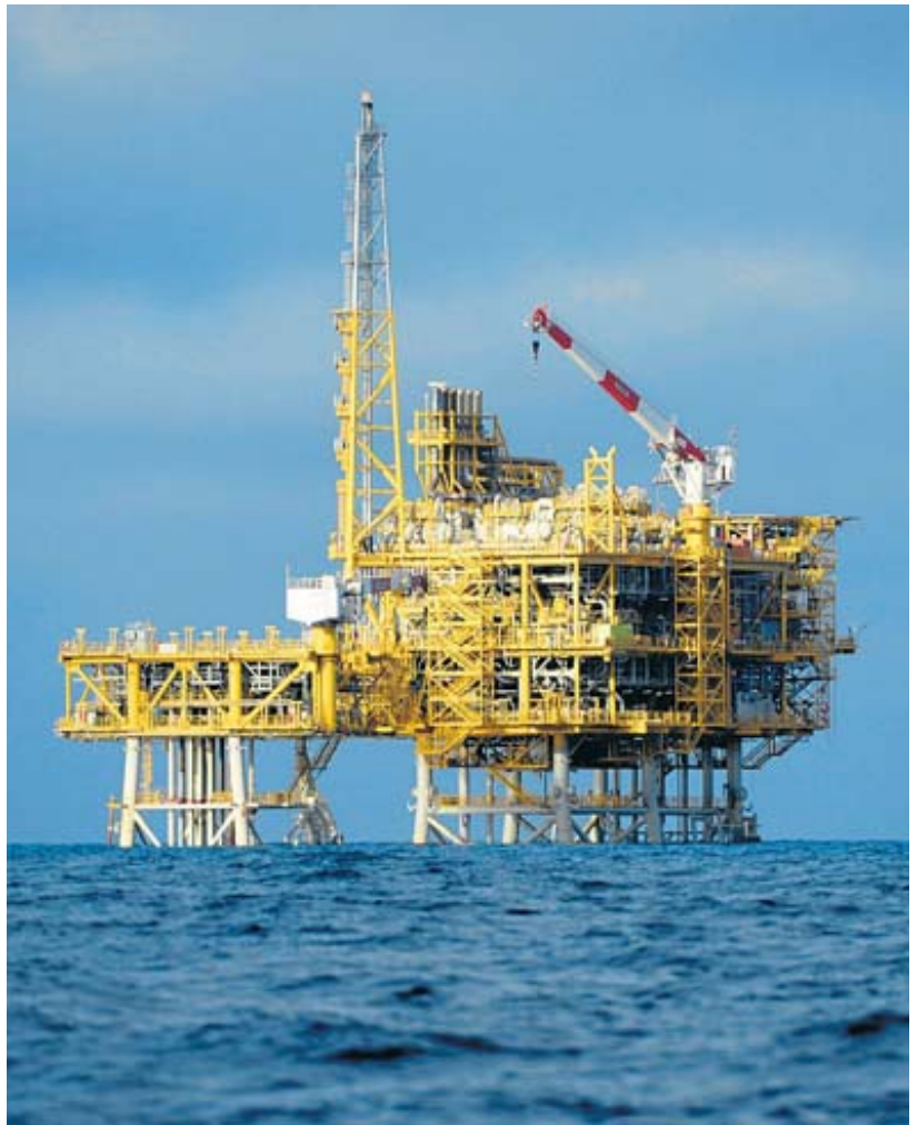
La planta marina del projecte Castor, davant d'Alcanar i Vinaròs, va provocar petits sismes entre el setembre i l'octubre que van causar alarma a la població. LLUIS GENÉ / AFP
