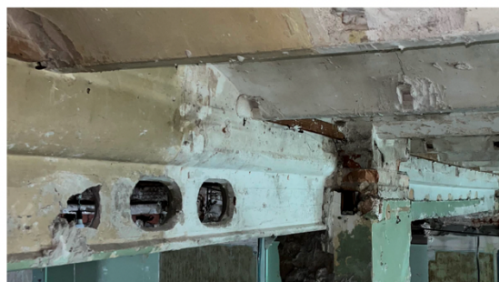
De d'esquerra a dreta: Secció tipus jàssera SEMPER-ITA Estat actual jàsseres de formigó
