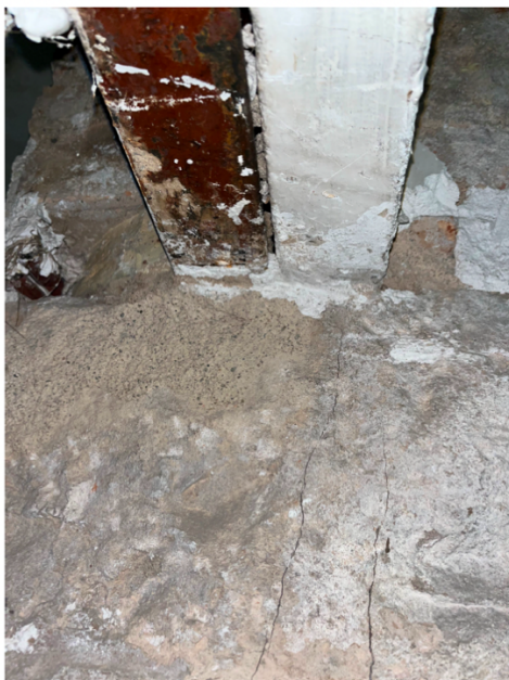
Estat actual jàsseres i biguetes metàl·liques
