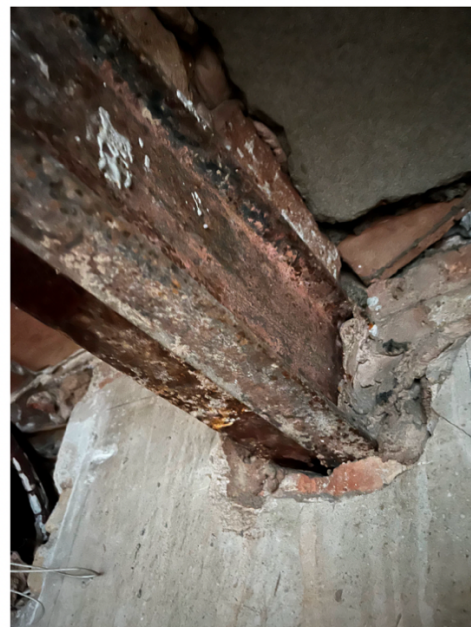
Estat actual jàsseres i biguetes metàl·liques
